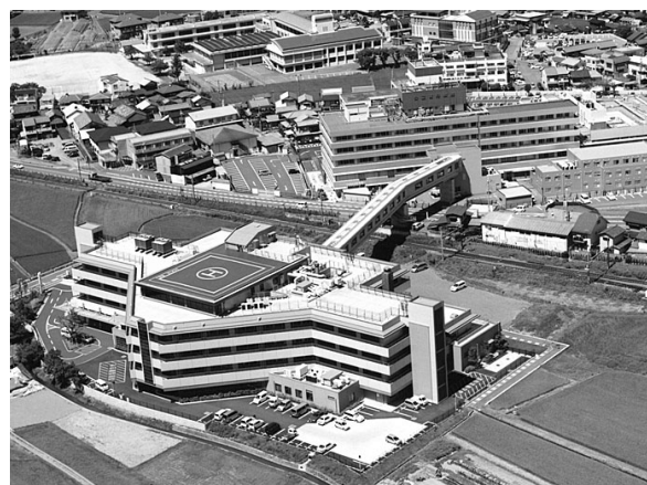
写真2 国道9号線とJR山陰線を越える連絡橋を有する新病棟(左側)
