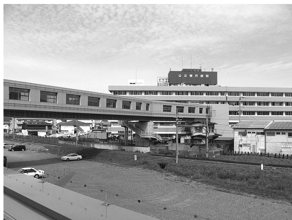
写真1 新病棟から見た連絡橋と旧病棟
